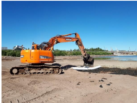
Stabilointityö käynnissä ©Ramboll Finland Oy
